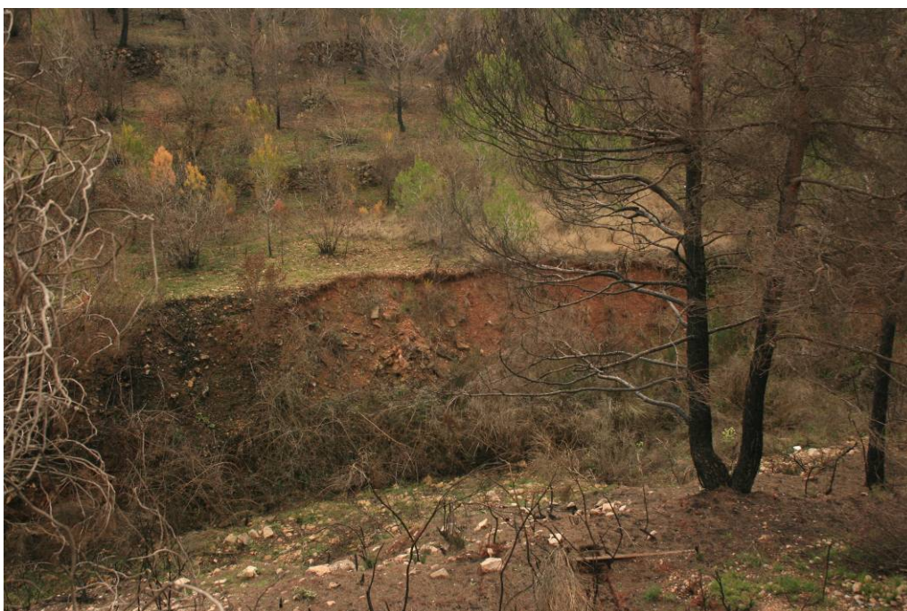
Fotografia 6: Petit lliscament per soscavació al marge sud del barranc de les Comes Joanes.
